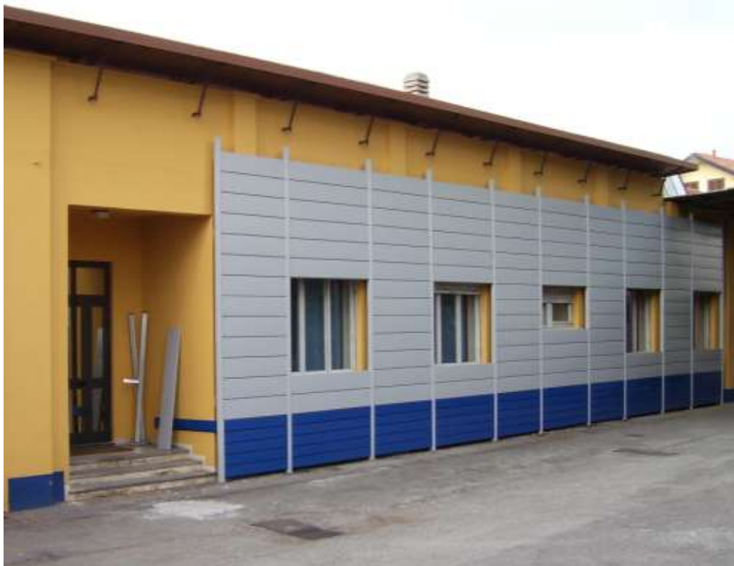
Facciata in corso di copertura
